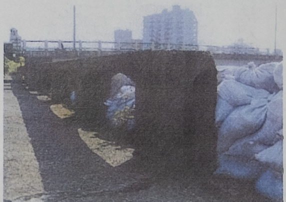
板田橋下流左岸 台風の後で撮影
