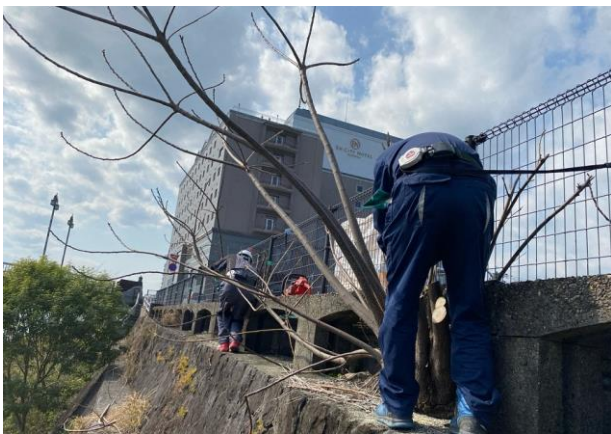
コンクリートの割れ目から生える雑木は、堤防を傷める原因になります。エンシティホテル延岡下流のこの場所では、作業前は盛大に生えていました（写真右）。左は作業後の様子
