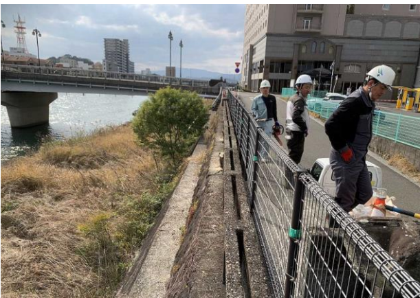
コンクリートの割れ目から生える雑木は、堤防を傷める原因になります。エンシティホテル延岡下流のこの場所では、作業前は盛大に生えていました（写真右）。左は作業後の様子
